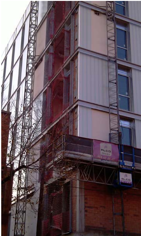
Ilustración 3 Edificación con protección pasiva
