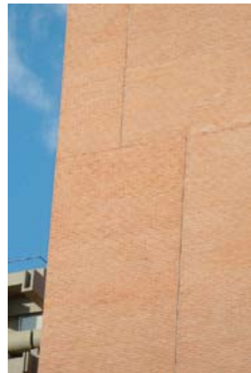
Sustitución de ladrillos erosionados
