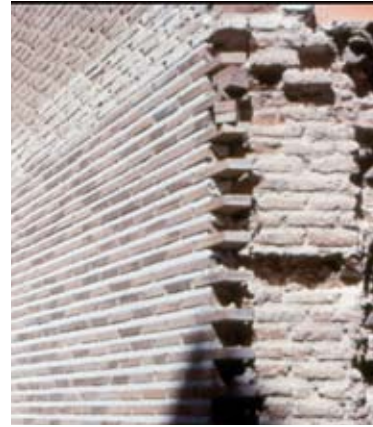
Muro portante Parador La Granja
